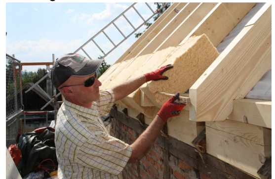
Dachdämmung von außen
